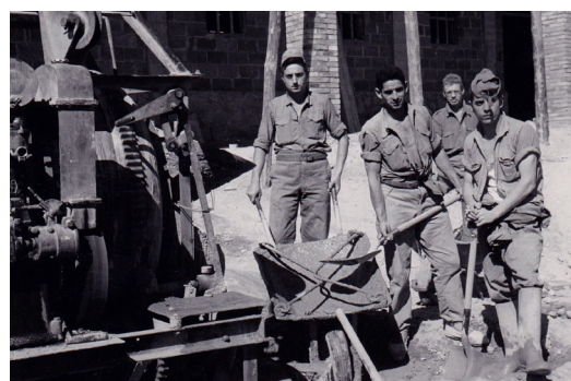
Construcción de los edificios de la Academia.
